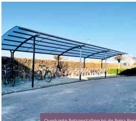
Overkapte fietsenstalling bij de firma Besix.
